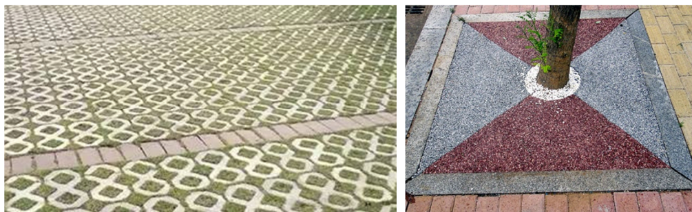
图2-5 停车区透水铺装示意
