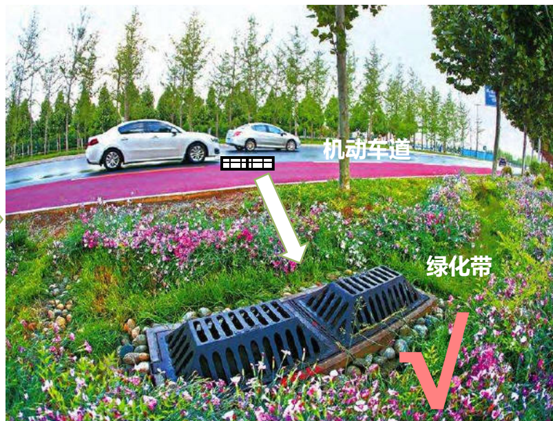
环保型雨水口——设置在绿化带中
