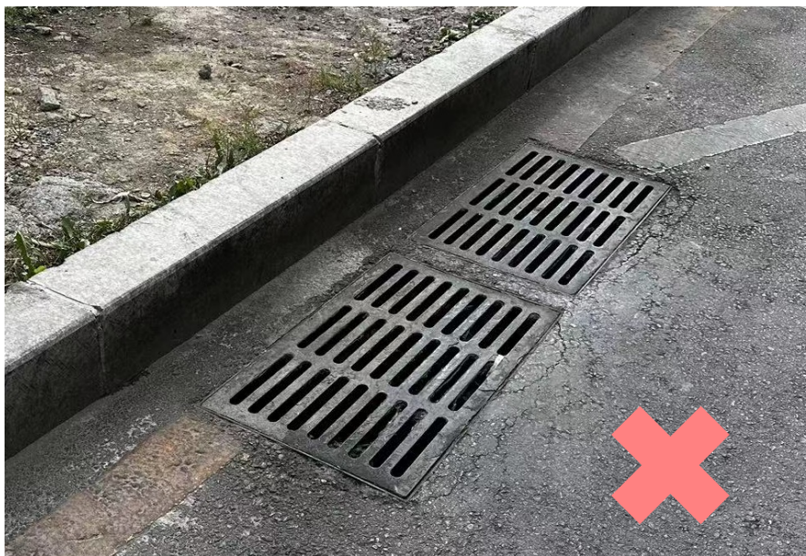
传统雨水口——在机动车道路侧
