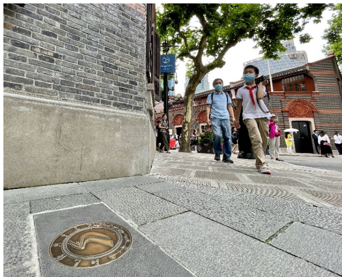
结合路面铺装的指示标识
