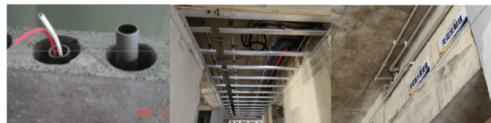
墙板空腔敷设管线
