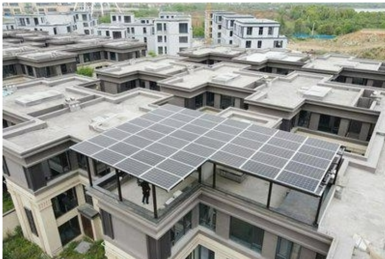
平屋面敷设光伏板
