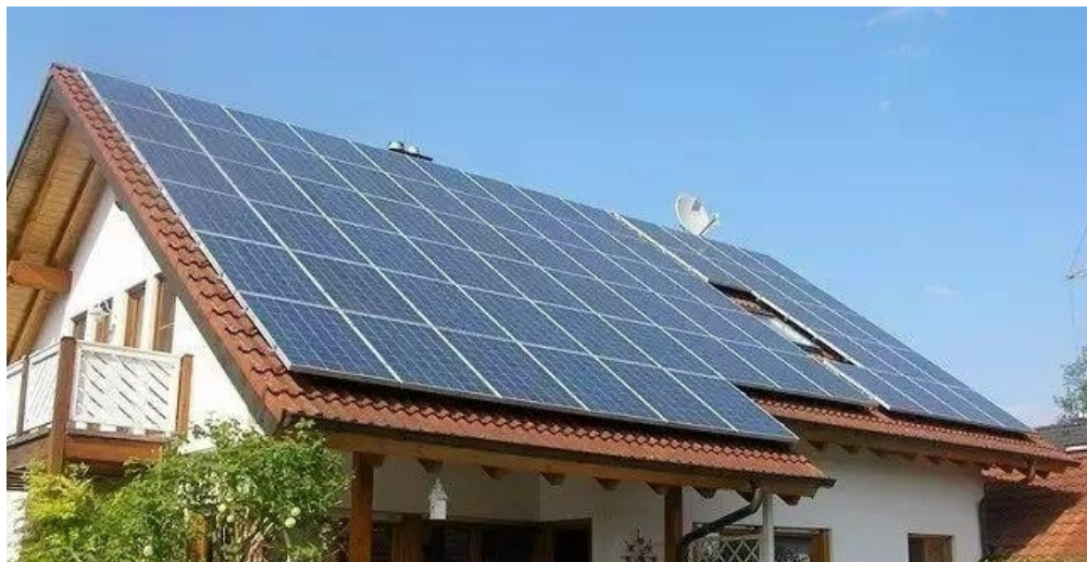
坡屋面敷设光伏板
