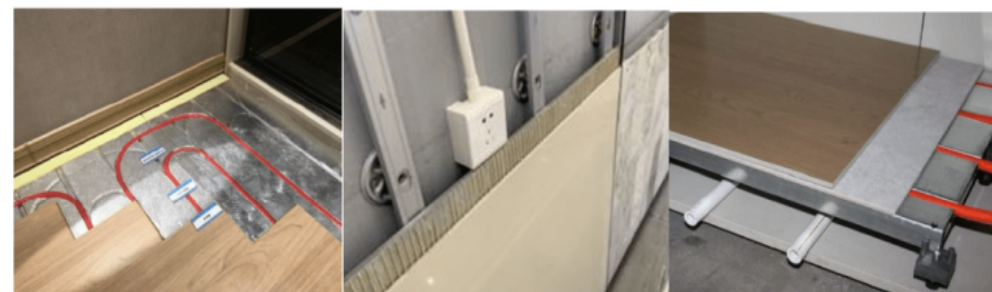
架空地面敷设暖管
