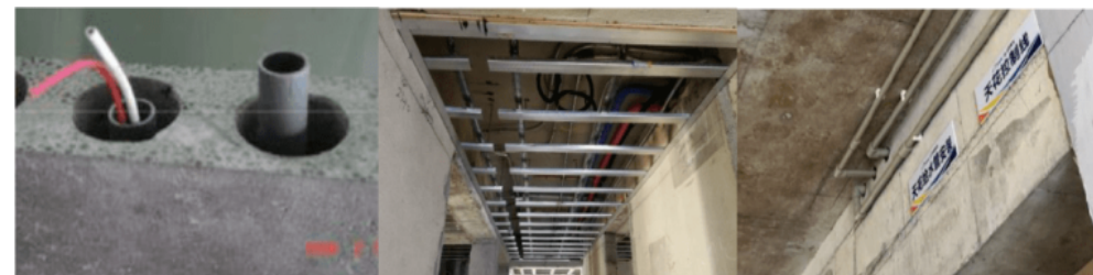
墙板空腔敷设管线
